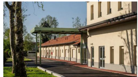
Fine lavori Residenza 20
