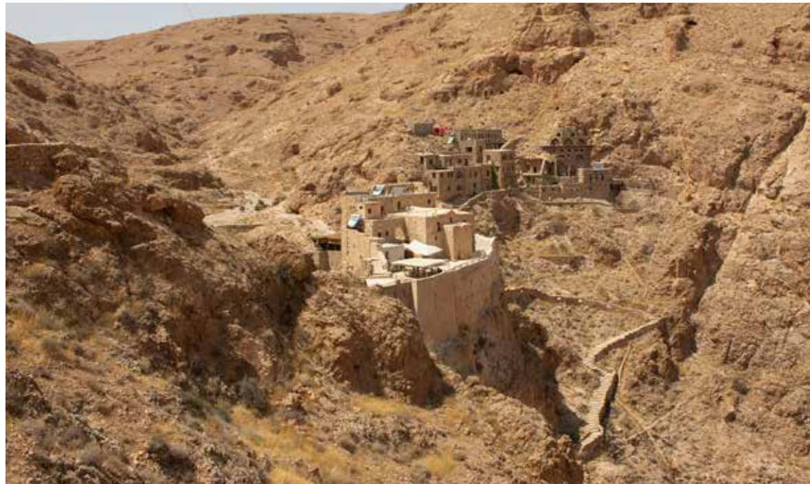
Il monastero dall'alto: in primo piano la struttura più antica (estate 2019)
